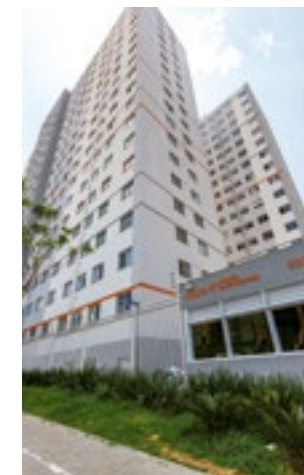
Vibra Estação Capão Redondo
